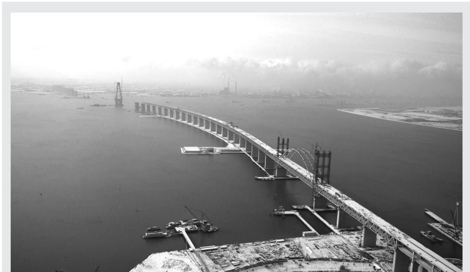
日前,由中交二航局承建的沪通长江大桥一标段准确铺装完成最后一根铁路槽型梁,标志着沪通长江大桥一标段主体工程顺利结束。据悉,沪通长江大桥作为沪通铁路的关键性和控制性工程,为沪通铁路、通苏嘉城际铁路、锡通高速公路共建通道,为4线铁路和6车道高速公路的公铁两用大桥。大桥全长11072米,主体结构共耗用钢材48万吨,混凝土约230万方,与36公里长的杭州湾跨海大桥的混凝土量相当(245万方),工程总投资约150亿元,工期54个月。
