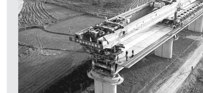
隆冬时节，在京九高铁合(肥)至安(庆)区段162公里工地上，机械隆隆，号声彼伏。建设者们保安全、保质量、保节点劳动竞赛如火如荼。图为12月12日，大型机械在中铁四局建筑公司肥西8598米花岗特大桥上紧张架梁。
